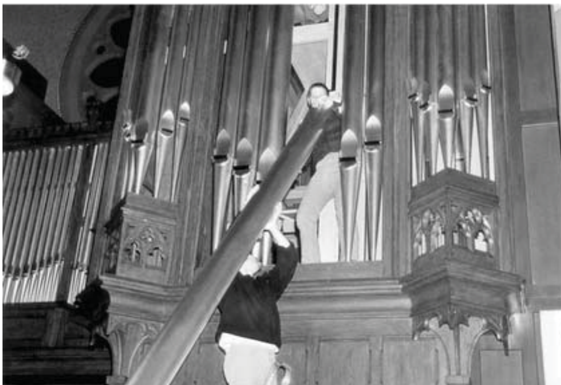
remontage des tuyaux de facade
